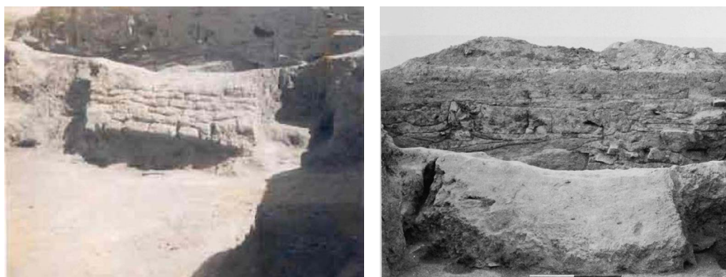
شکل ۶: گودین III2؛ دیوار بین دو اتاق از پایین در خط کف جدا شده و سقوط کرده است (Young, 1969: 127). Fig. 6: Godin III2: The wall between the two rooms has separated from bottom of the room floor and has fallen (Young, 1969: 127).
